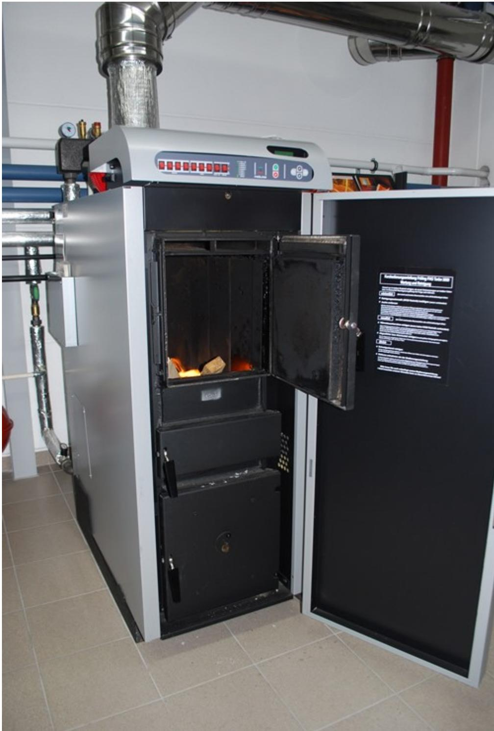
Dieser vollautomatische Kessel für Hackgut-, und Pelletsfeuerung ist komfortabel, robust, sparsam und sicher. Mit seinem Appetit auf Hackgut, Späne und Pellets verfügt er über nahezu universelle Einsatzmöglichkeiten. Selbst ein Scheitholznotbetrieb ist nach Einlegen eines Spezialrostes mit wenigen Handgriffen möglich. Ob Hackgut, Späne, Pellets oder Miscanthus, der Kessel stellt sich auf jeden Brennstoff automatisch ein.
