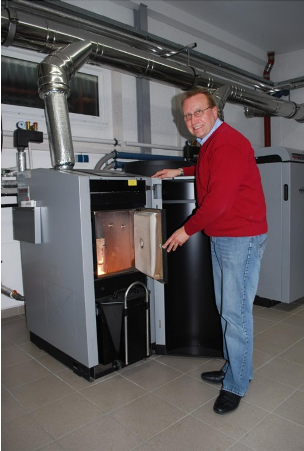
Mit diesem komfortablen Pelletskessel hat der Betreiber so gut wie keine Arbeit mehr. Brennstofftransport, Zündung, Verbrennungsregelung, Reinigung und Entaschung funktionieren vollautomatisch. Die patentierte Pellettschleuse sorgt für die Sicherheit dieser Holzheizung. Der Brennstoffverbrauch ist sparsam, der Kessel hat eine lange Lebensdauer.
