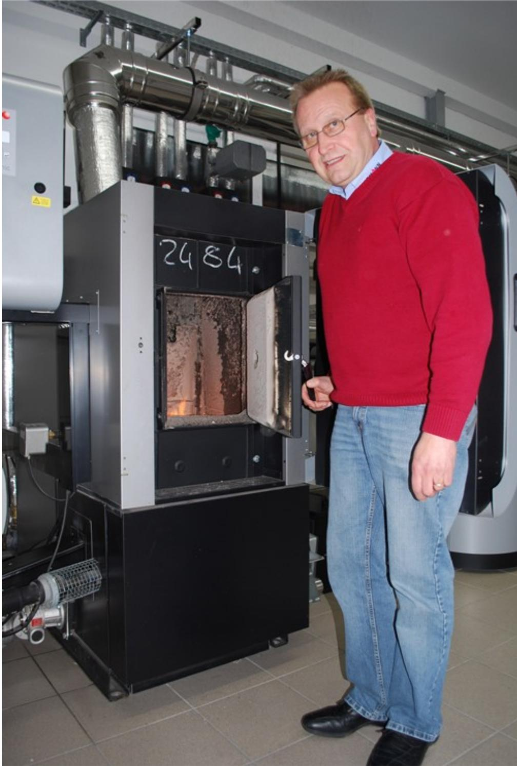
Dieser Scheitholzessel kann bequem mit Holzscheitern befüllt und anzündet werden, den Rest erledigt er von alleine. Ein robuster Hebel erlaubt ein bequemes Reinigen der Heizflächen von außen, hohe Wirkungsgrade sind die Folge. Und ohne Rauch geht's sowohl beim Anheizen, als auch beim Nachlegen - eine saubere und bequeme Angelegenheit.
